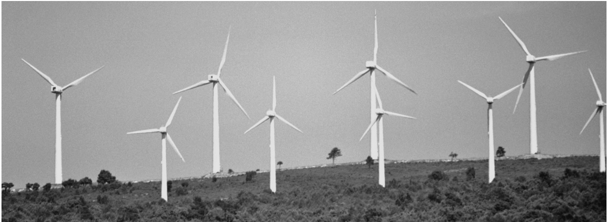
Vista parcial de la central eòlica de Trucafort. (Foto: Tarroja)
