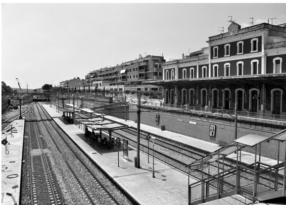
La construcció del ferrocarril d'alta velocitat permetrà soterrar les vies i l'estació del ferrocarril a Vilafranca del Penedès, que actualment travessen la ciutat en trinxera. (Foto: Tarroja)
