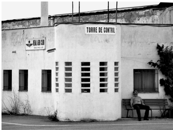
Detall de les instal·lacions de l'aeròdrom d'Alfès. (Foto: Tarroja)
