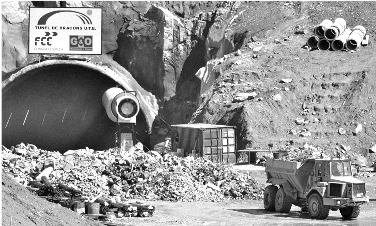
Aspecte dels treballs d'obertura del Túnel de Bracons a Sant Andreu de la Vola, al municipi de Sant Pere de Torelló. Engagats el mes d'abril del 2003, els treballs van quedar momentàniament paralitzats durant el procés electoral autonòmic. (Foto: Tarroja)
