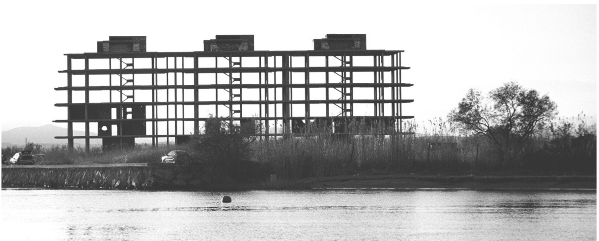
L'enderroc de l'estructura de sis plantes construïda als anys setanta hauria de donar peu a la integració dels terrenys al Parc Natural dels Aiguamolls de l'Empordà connectant així les reserves naturals de la Llauna i Carmanyas. (Foto: Tarroja)
