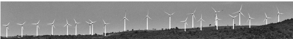
La compatibilització entre la necessitat de promoure les energies renovables i l'impacte paisatgístic que ocasionen en els espais naturals, ha generat un important debat social. A la imatge un detall de la central eòlica de Trucafort, a cavall del Priorat i el Baix Camp. (Foto: Tarroja)
