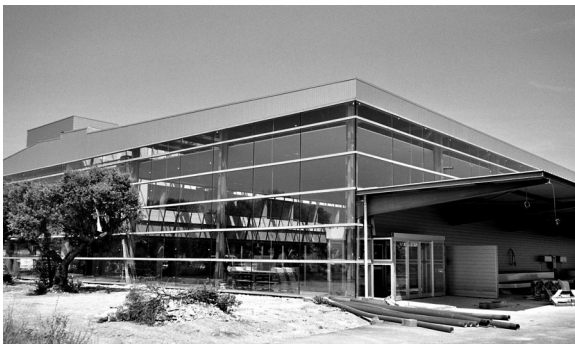
El nou terminal d'arribades, en construcció, és una de les primeres actuacions per a l'ampliació de l'aeroport de Reus. (Foto: Tarroja)
