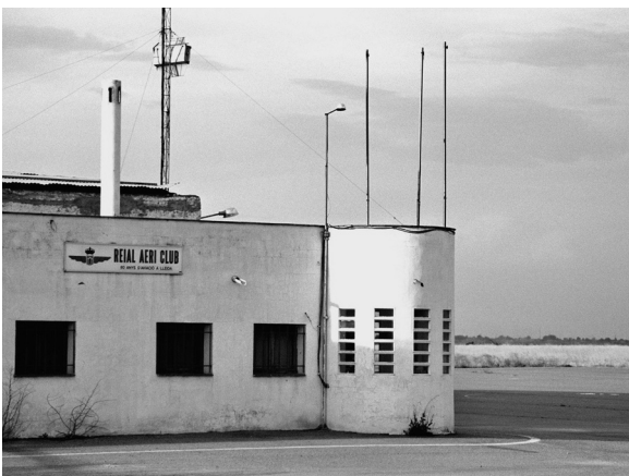
El pla d'aeroports de Catalunya proposava transformar l'aeròdrom d'Alfés, que actualment té un ús esporàdic, en aeroport regional de Lleida i en preveia ampliar la pista d'aterratge i les instal·lacions. (Foto: Tarroja)
