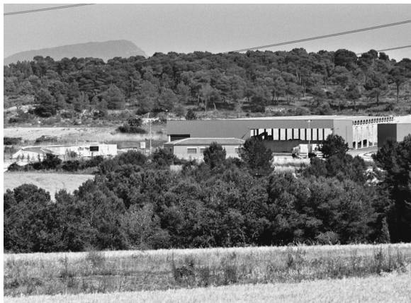
Instal·lacions del centre de tractament de residus de la Conca de Barberà al paratge del Pla Norè, entre l'Espluga de Francolí i Blancafort. (Foto: Tarroja)
