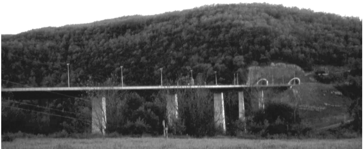
El nou tram de l'Eix Pirinenc va alliberar el centre de Castellfollit de la Roca del trànsit d'uns 15.000 vehicles diaris. El cost i l'impacte visual de la construcció d'un viaducte de 500 m i de quatre túnels van comportar protestes d'entitats ecologistes. (Foto: A. Jiménez)
