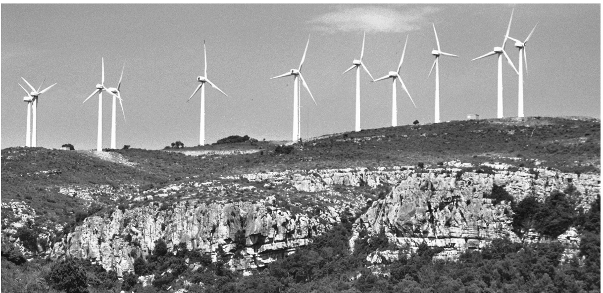
Detall de la central eòlica de Trucafort, construïda entre 1998 i 1999 a cavall dels municipis del Pradell de la Teixeta, la Torre de Fontaubella (Priorat), Collejou i l'Argentera (Baix Camp). La central consta de noranta-un aerogeneradors. (Foto: Tarroja)
