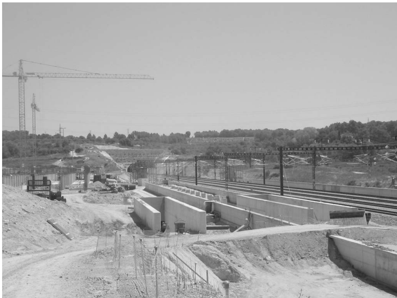
Imatge de les obres de construcció de l'estació del FAV entre els municipis de la Secuita i Perafort. Foto: Júlia Rubert
