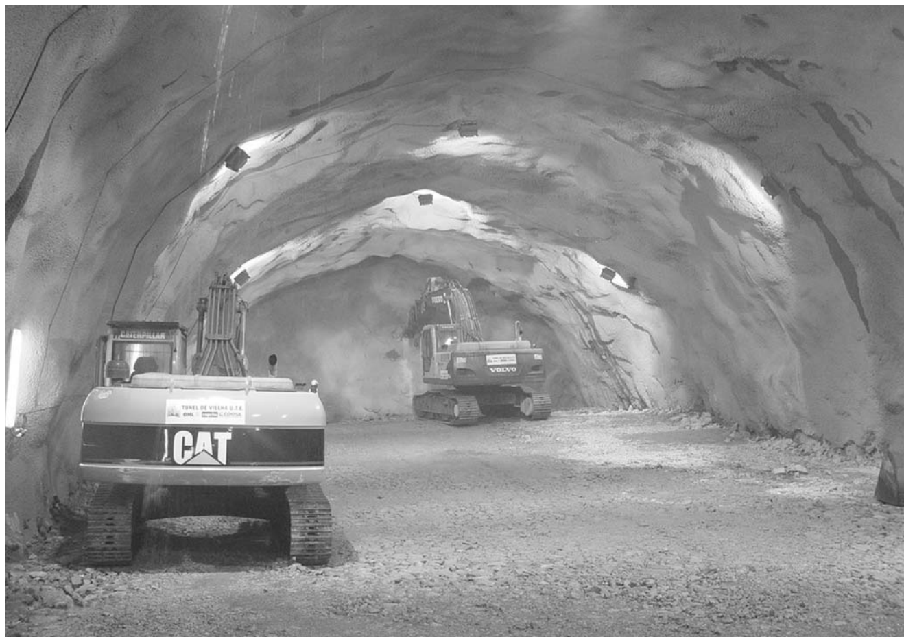
El traçat del nou túnel de Vielha avança paral·lel a l'antic i tindrà una longitud de 5.029 metres. En la imatge, màquines treballant a l'interior del túnel. Foto: Arxiu del Conselh Generau d'Aran
