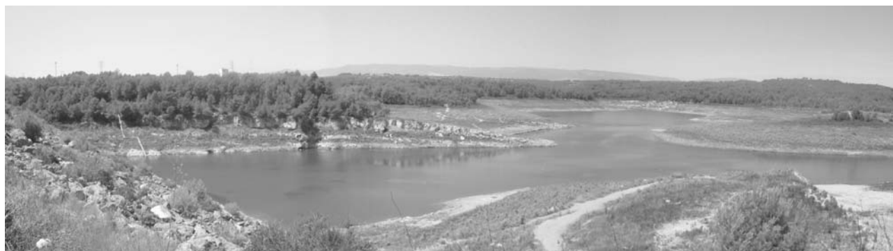
La construcció de l'embassament del Gaià, en la imatge, va provocar la desaparició del cabal del riu al seu tram final. Foto: Júlia Rubert
