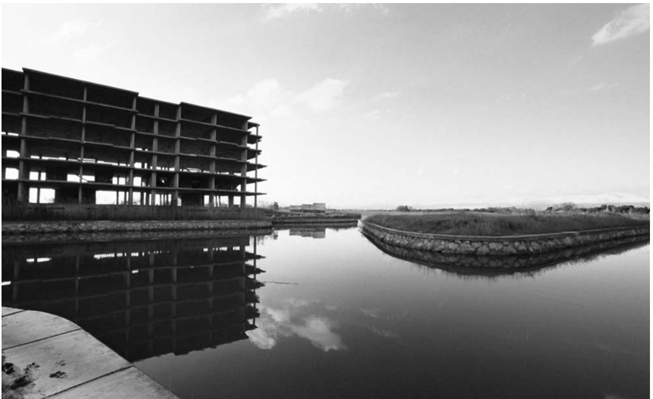
El Departament de Política Territorial i Obres Públiques va adquirir una parcel·la de Fluvianàutic per procedir a l'enderroc de l'edifici a mig construir. Foto: Àlex Tarroja
