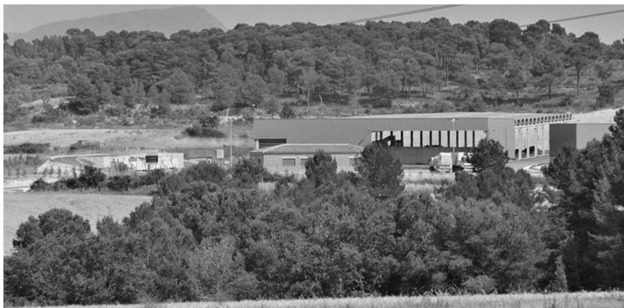
Un informe encarregat pel DMAH haurà d'establir si l'abocador s'ha construït sobre un aqüífer. Foto: Àlex Tarroja
