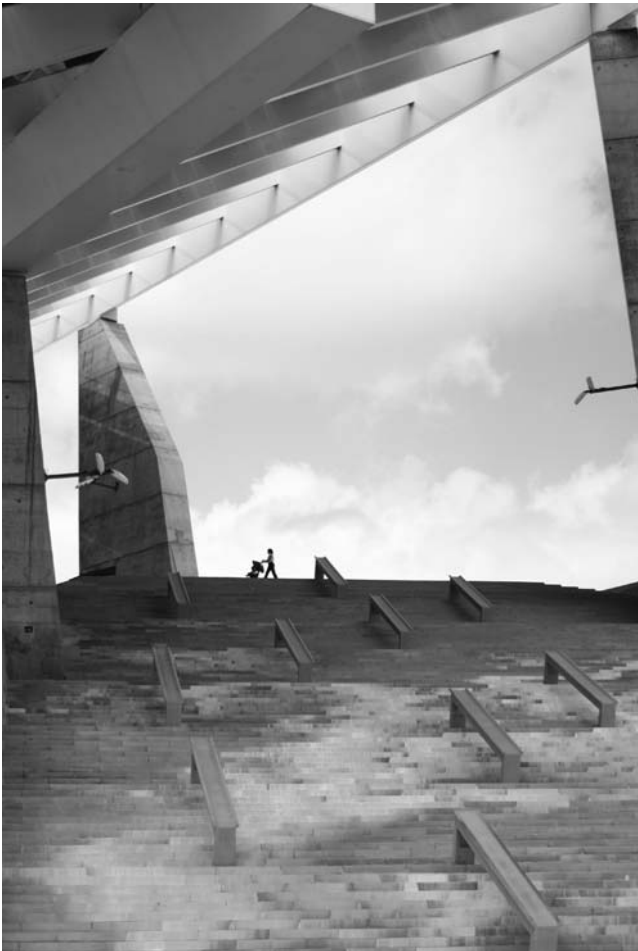
El foment de les energies renovables contribueix a la reducció de les emissions de gasos amb efecte hivernacle. En la imatge, la placa fotovoltaica del Fòrum a Barcelona. Foto: Marta Casas
