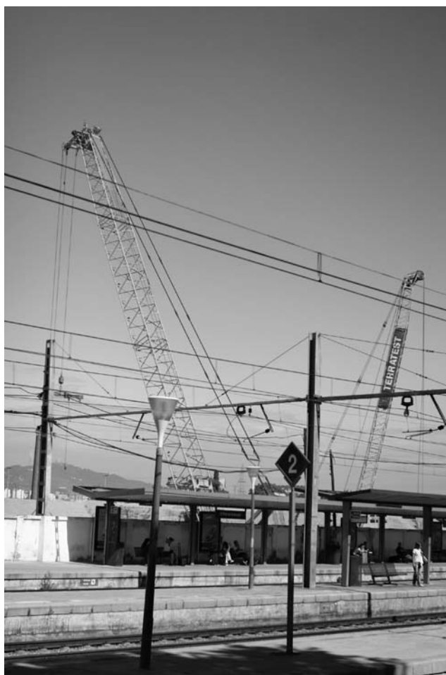
El Pla Delta s'haurà de coordinar amb altres obres que s'estan executant en el mateix territori com l'estació intermodal del Prat. En la imatge l'actual estació de ferrocarrils del Prat de Llobregat. Foto: Marta Casas
