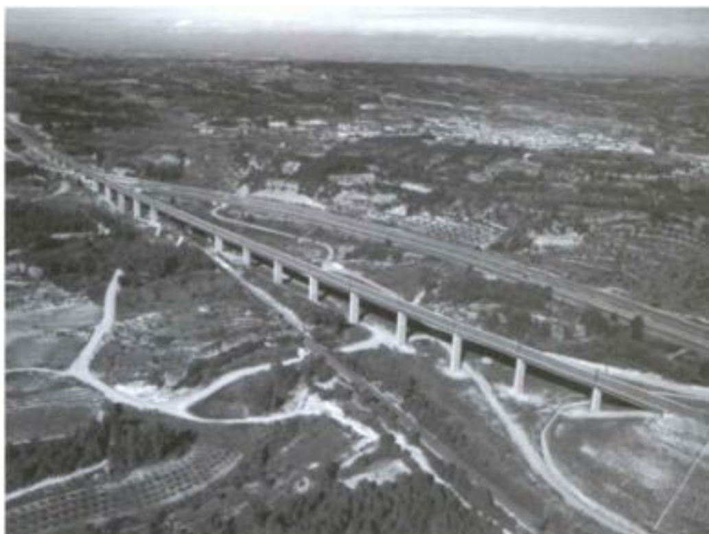
En la imatge, al seu pas pel viaducte de Vinalha. Foto: Adif
