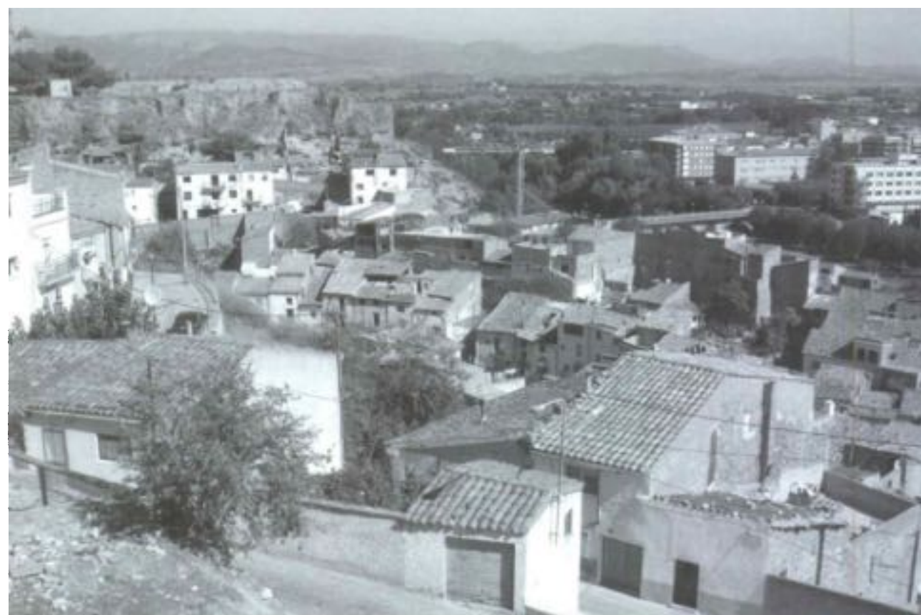
Un 40% de les edificacions del centre històric es trobaven en ruïna. Foto: Carles Valencia Navarro
