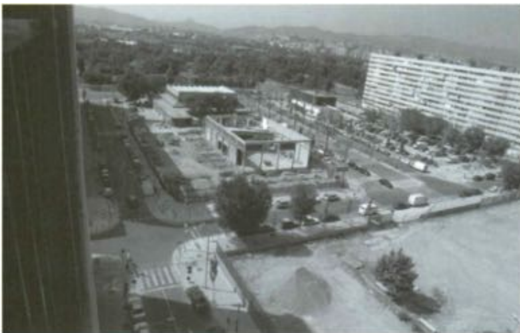
El primer tram del passeig, i equipaments nous. Foto: Ramon Llanús
