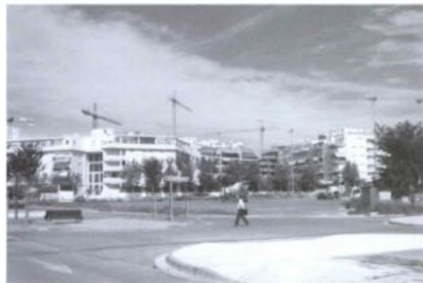
Uns PMU vinculats al POUM implicarien la demolició de blocs de pisos. Foto: Marta Casas.
