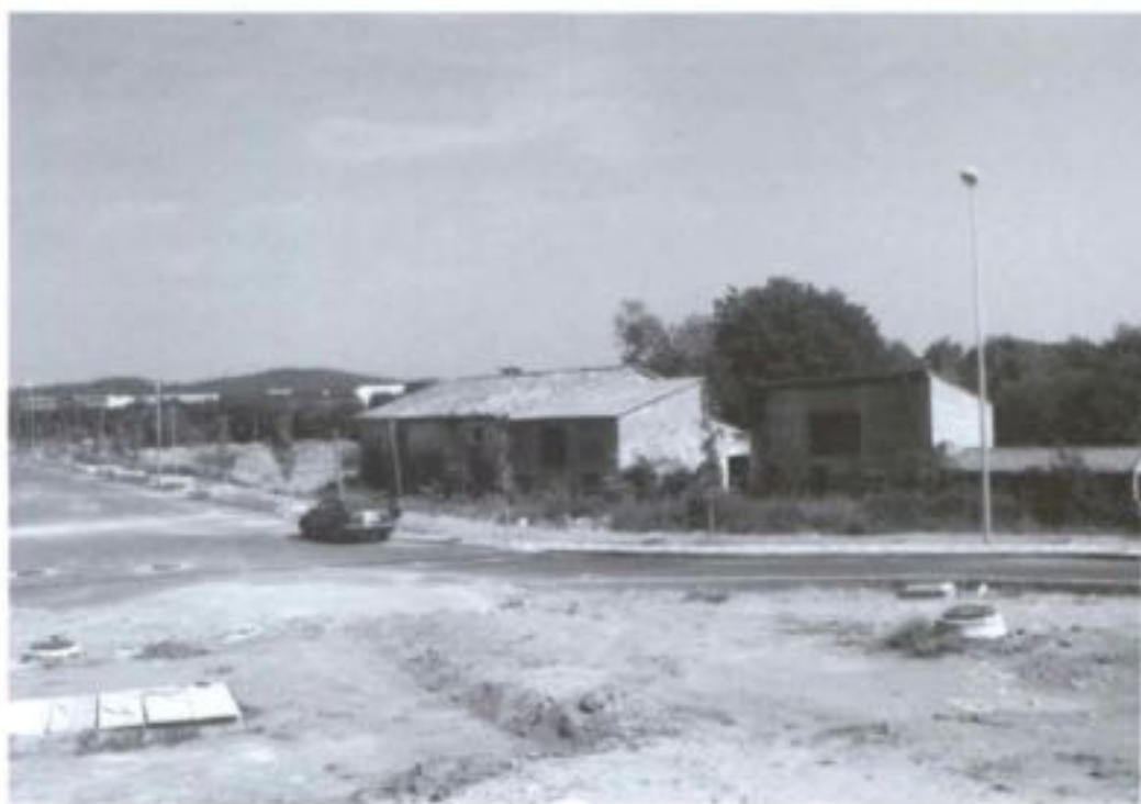
El pla preveu la construcció de 1.236 habitatges i el 26% serien HPO. Foto: Marta Casas.
