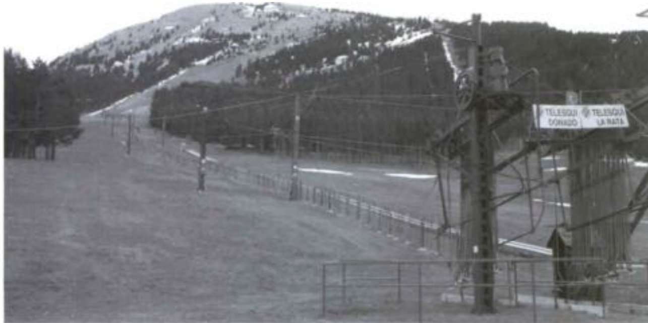
El projecte d'ampliació consisteix en incorporar 86 ha al domini esquiable. Foto: Àlex Tarroja
