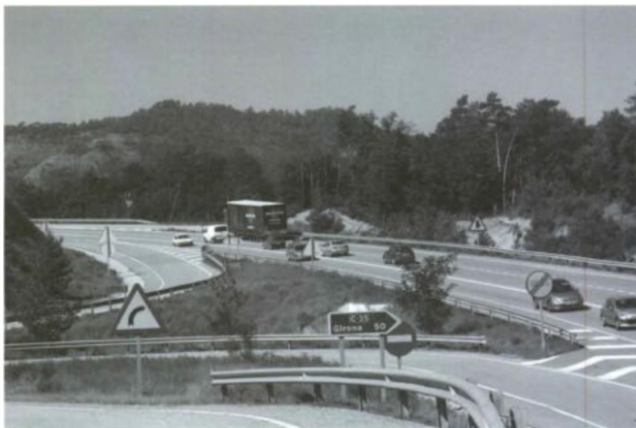
El projecte consisteix en desdoblament l'actual carretera per formar una autovia de dos carrils per sentit. Foto: Marta Casas.
